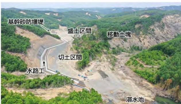
図－17 日高幌内川緊急対策工（上流側から）
