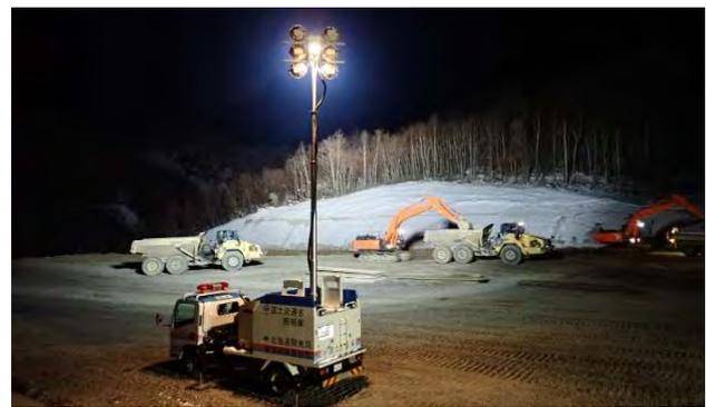
図-16 夜間施工状況 (ダンプは40t積アーティキュレイト)
