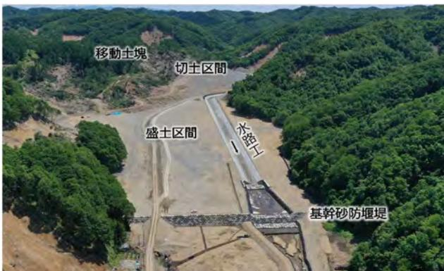
図－18 日高幌内川緊急対策工（下流側から）
