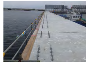
2) アンカーボルト設置
