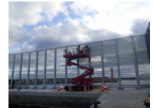
4) パネル設置状況
