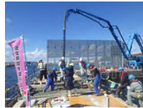
1) 上部工施工状況
