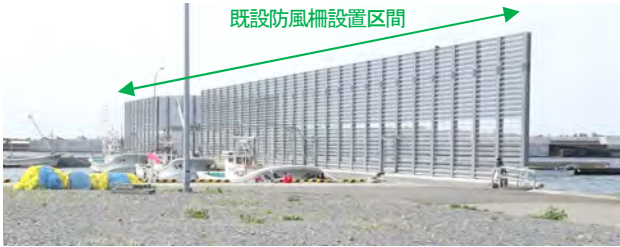
写真-4 既設防風柵設置状況
