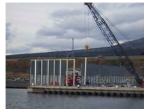
3) 支柱建込状況
