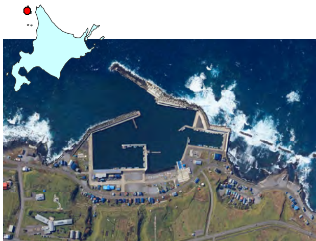
写真-1 仙法志漁港全景（令和元年10月撮影）
