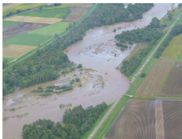
写真-1 流路変動による側岸侵食（音更川，2011年出水，帯広開発建設部提供）
