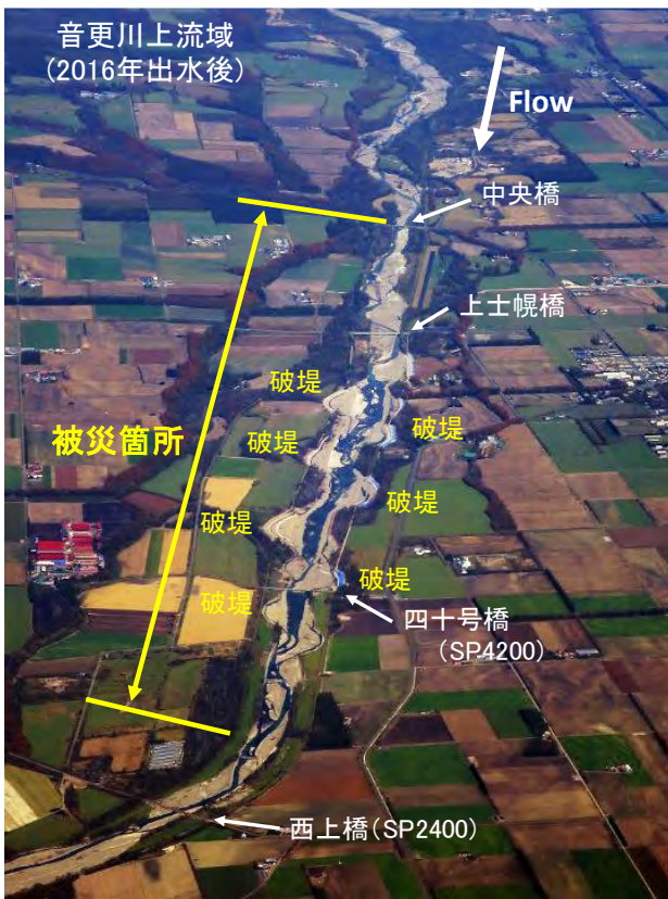
図-8 2016年北海道豪雨災害における音更川上流域の被災状況
