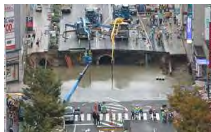
写真-1 博多駅前通り陥没
