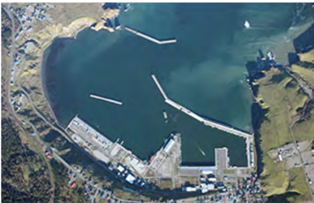
写真-1 落石漁港全景（平成27年10月撮影）
