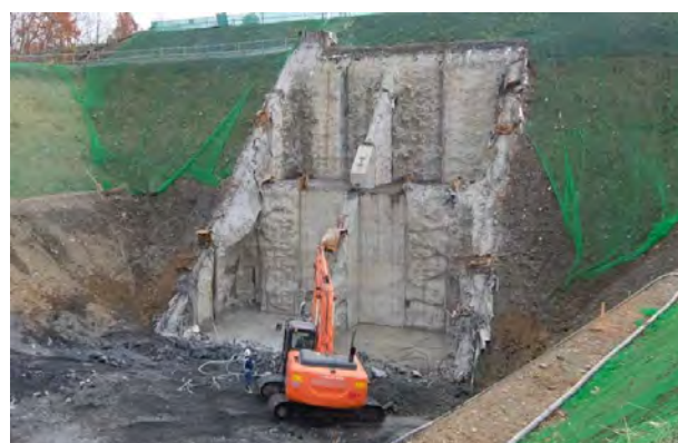
写真-2 箱型連続壁部分取り壊し後の状況
