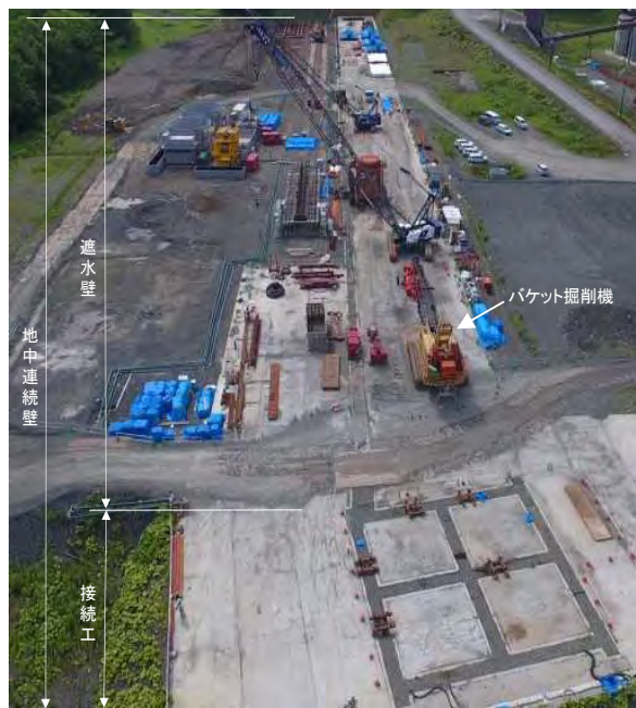
写真-1 地中連続壁の施工状況全景
