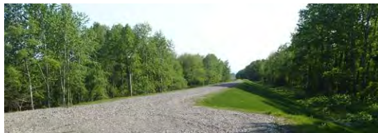
写真-1 堤防上から見る札内川の樹木繁茂状況
