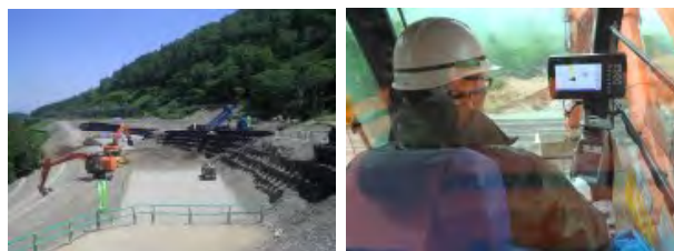
写真-14 類型5：対策状況全景
