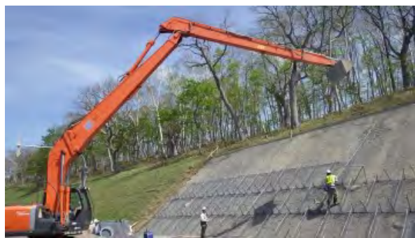
写真-12 類型3：基盤排水および法面ふとんかご施工状況
