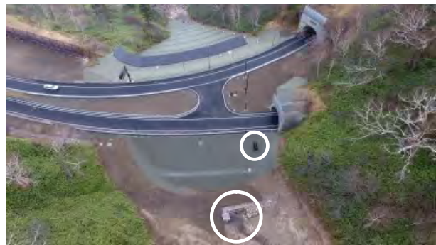
写真-6 類型1:対策状況全景
