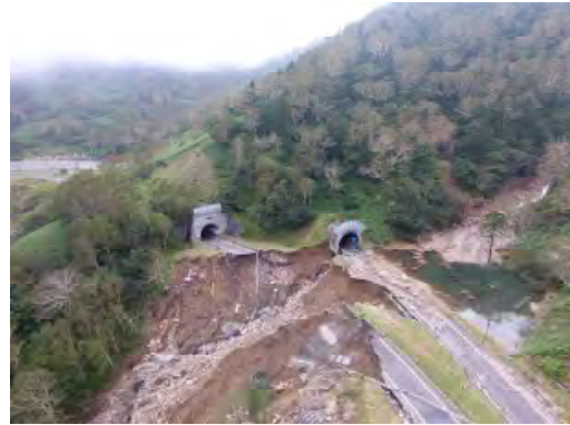
写真-1 類型1:石山トンネル起点 (撮影方向:起点→終点)
