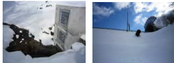
写真-7 類型1:嵩上げ柵(左)、類型1:追加横断管(右)
