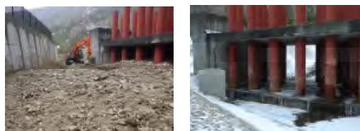
写真-11 類型2:土砂流の撤去と嵩上げ柵
