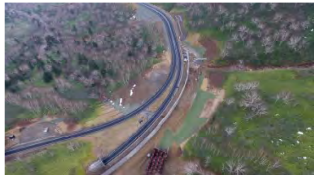
写真-8 類型2:対策状況全景
