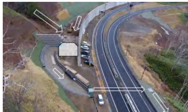
写真-9 類型2:排水の別ルート(水路と横断管)
