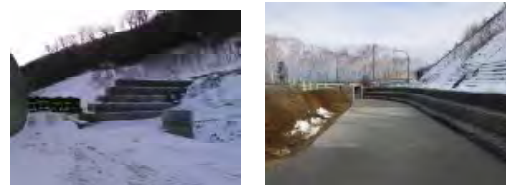
写真-10 類型2:大型かご枠(左)、管理用通路兼排水路(右)
