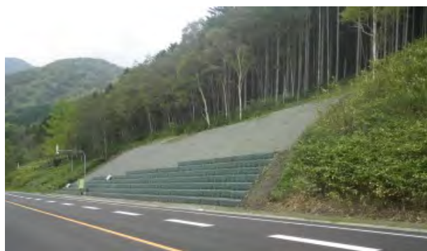
写真-13 類型5：対策状況全景
