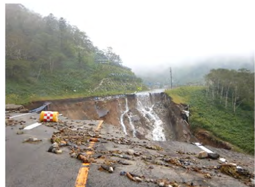
写真-3 類型2:起点側から流下する路面水 (撮影方向:終点→起点)
