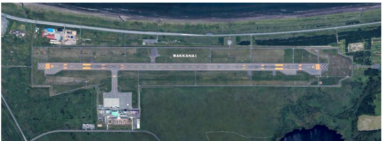
写真-2 稚内空港全景 [平成26年(2014) 8月29日 撮影]
