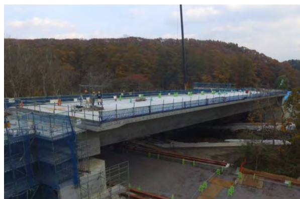
図-21 R橋(上り線)全景
