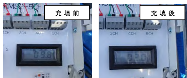
図-17 グラウト充填確認
