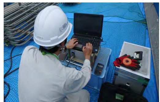
図-14 緊張力測定状況
