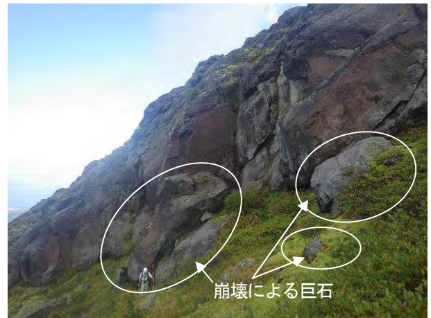
写真-1 崩壊形態状況
