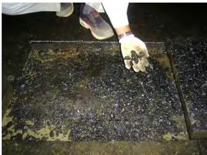
写真-1 水分の浸入による基層のはく離
