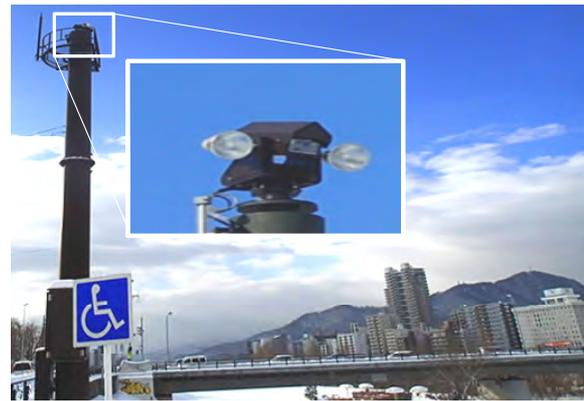
図8. CCTV装置の設置状況(豊平川)
