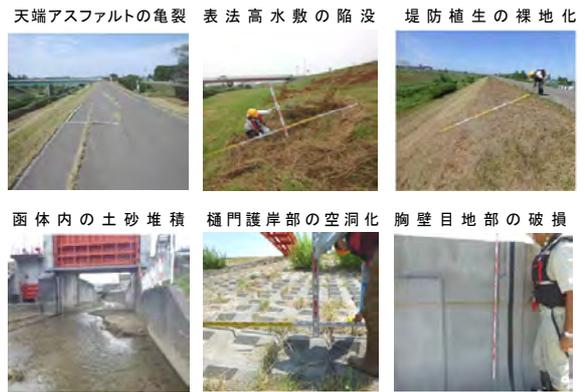
図4. 堤防点検の代表的な変状
