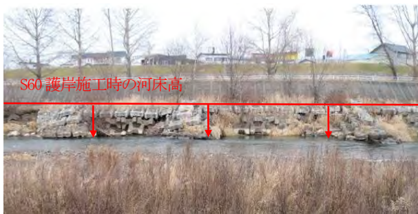
写真-1 KP6.2付近の護岸の状況
