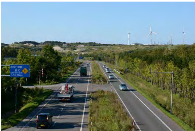
図-12 更喜苦内防雪区間に設置したゆずり車線および中央帯
