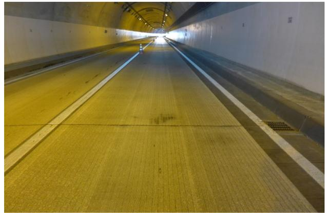
写真-4 DG工法施工後の路面
