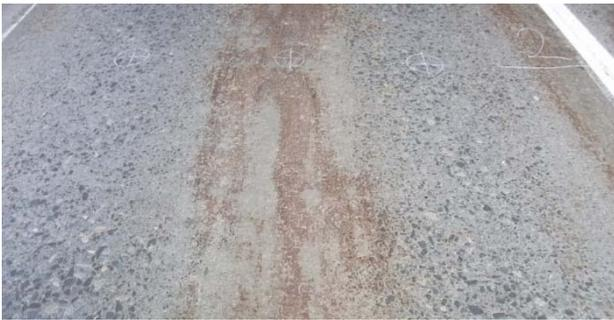
写真-3 除雪車の刃により表面が削られた路面
