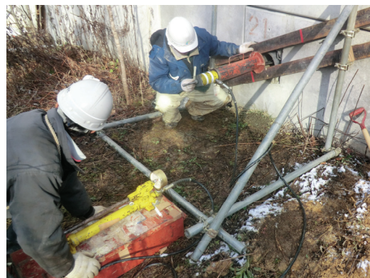
図-5 現場引抜き試験の状況
