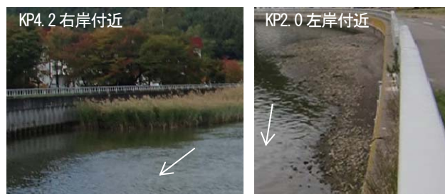
写真-3 矢板劣化の生じていない範囲の矢板前面状況
