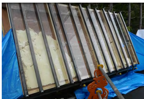
写真-5 ウレタンの拡散状況①
