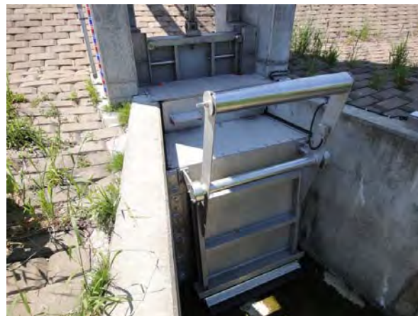
図-5 予備ゲート設置状況写真
