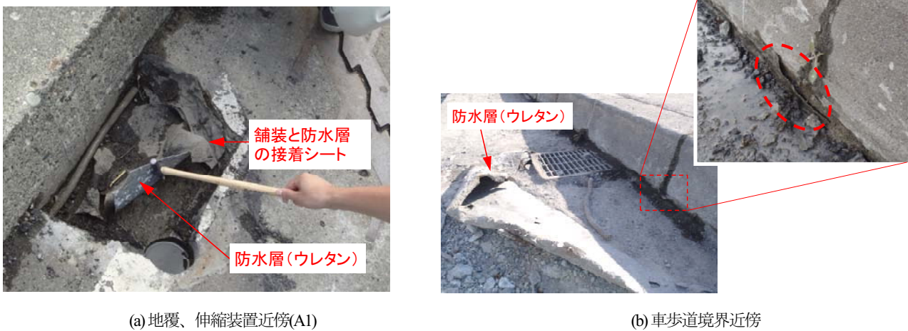
図-4 防水層の状況
