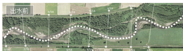
写真-2 出水前の状況（H22年8月撮影）
