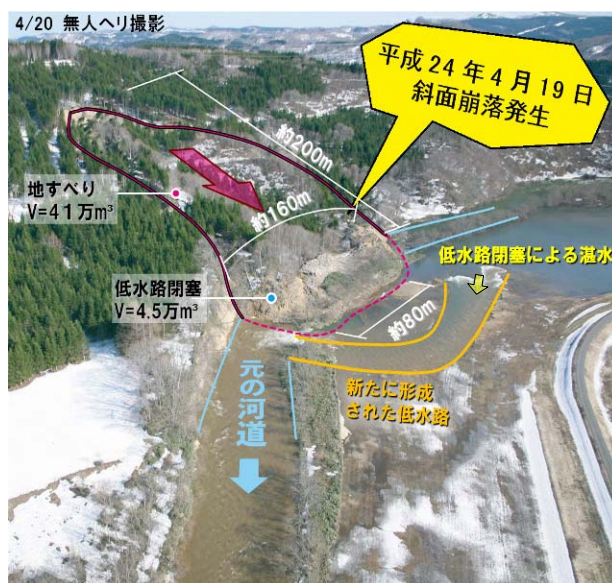
図-2 斜面崩落の規模
