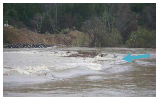
図-13 出水状況（仮橋箇所）
