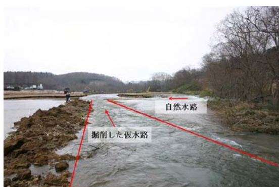
図-10 仮水路上流から自然水路を望む
