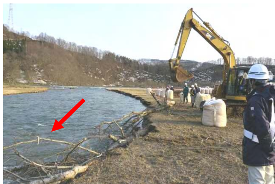
図-9 木流し工施工の様子
