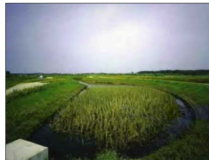
写真-5 遊水池の整備状況
