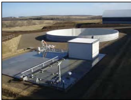
写真-1 配水調整池の整備状況
