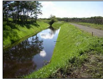
写真-3 排水調整池の整備状況
