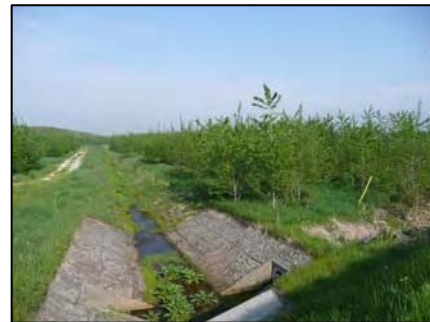
写真-4 土砂緩止林の整備状況
