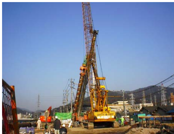
写真-1 斜杭の施工状況
