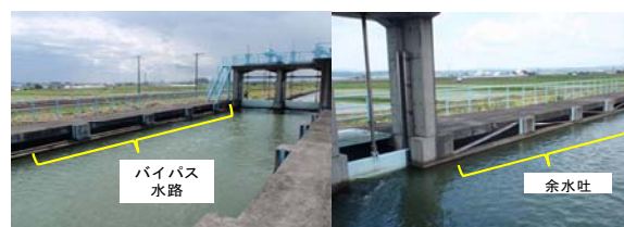
写真-2 水位調整施設のバイパス水路と余水吐
