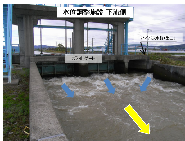
写真-1 水位調整施設の事例
