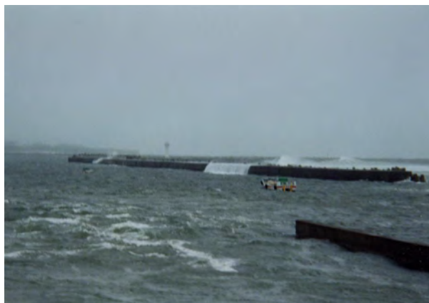
図-12 歯舞漁港 南防波堤越波状況
