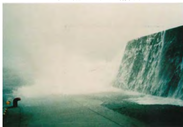
図-17 瑠瑠瑠漁港 東護岸越波状況
