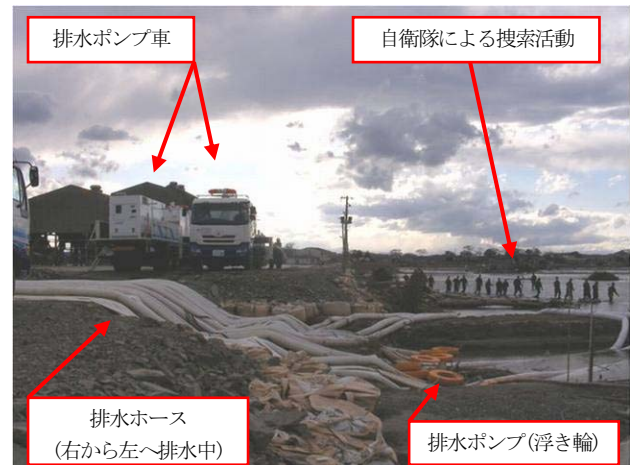
写真-1 排水作業状況
