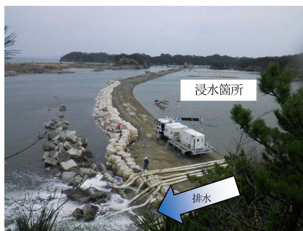
写真-3 排水状況(潜ヶ浦ブロック)
