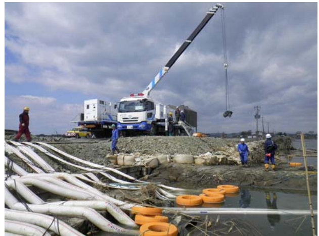
写真-8 クレーンによるポンプ設置作業 (2台のうち左側の排水ポンプ車はクレーンを装備していないため、右側車両のクレーンを使用してポンプを設置した。)
