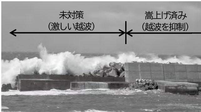
防波堤の嵩上げによる越波対策
