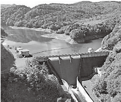
神居ダム (取水放流設備の改修、耐震化等)
