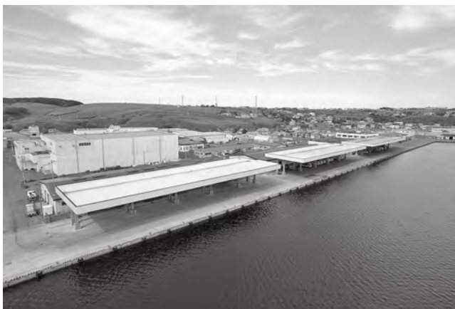
根室港 屋根付き岸壁（令和7年供用）
