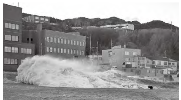
荒天時の越波等による港内擾乱状況 (香深港)
