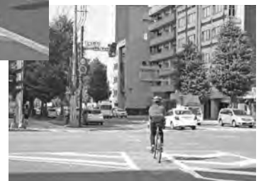
自転車の通行位置を示す矢羽根型路面表示の設置例 一般国道230号（札幌市）
