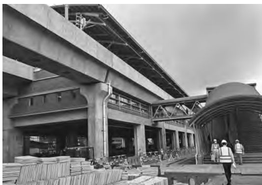
建築中のMRT 6 号線ウットラノース駅（外観）
