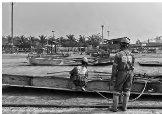
シブプリサイクルヤードでの解撤作業状況
