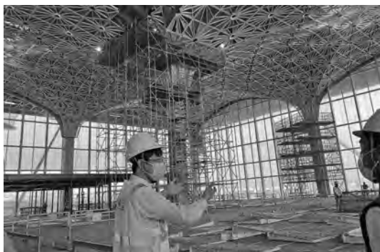
ダッカ空港国際ターミナル建設現場視察状況
