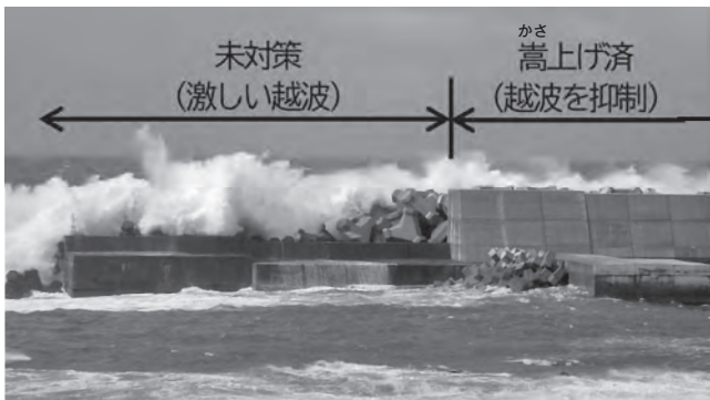
防波堤の嵩上げによる越波対策
