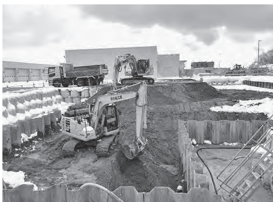
函館空港 浸水対策施工状況
