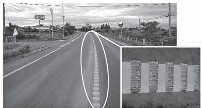
正面衝突事故対策：ランブルストリップス （国道5号 八雲町）
