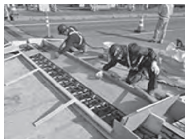
構造物の修繕（伸縮装置補修）
