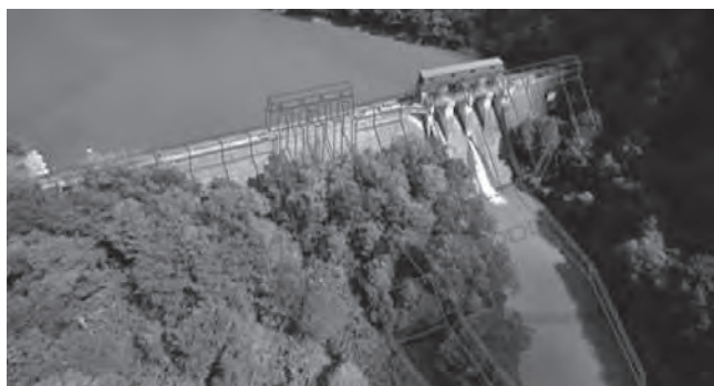
雨竜第2ダム（堤体嵩上げ・容量振替）
