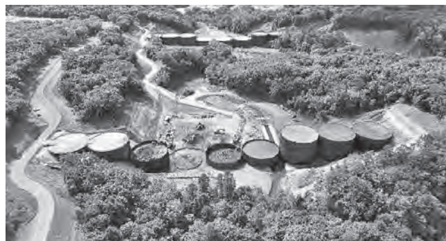
熊の沢川3号砂防堰堤 えんてい
