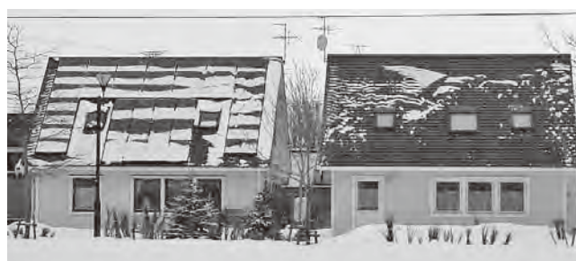
写真 1 太陽電池搭載屋根（左）と塗装鋼板屋根（右）
