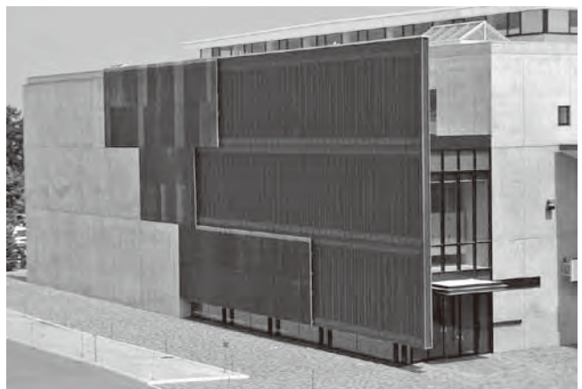
写真2 建物外壁に設置した太陽電池モジュール
