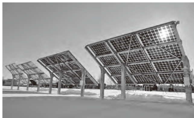
写真3 両面受光型太陽電池を使用したアレイ
