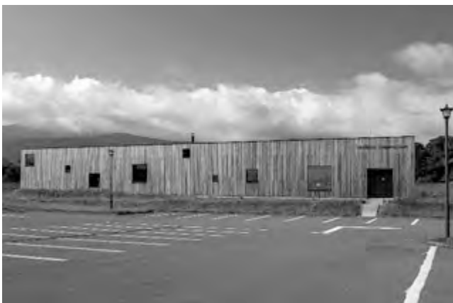
積丹ブルー蒸溜所 外観
