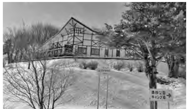
移住相談拠点施設（改修前）
