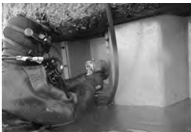
老朽化対策(被覆防食)
