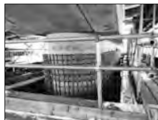
緊急輸送道路上の橋梁の耐震補強
