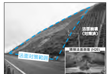
道路斜面の防災対策
