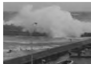
防波堤からの越波・港内擾乱
