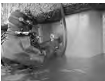
被覆防食による長寿命化対策
