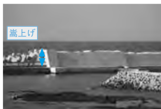
防波堤の嵩上げによる越波対策
