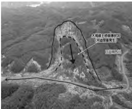
日高幌内川 大規模土砂崩落の状況
