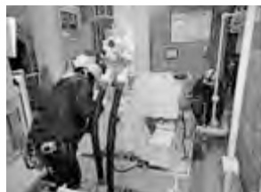
施設の点検（放流設備）
