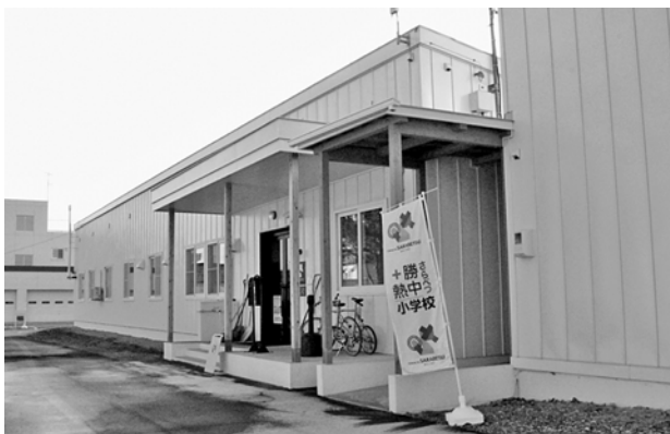
十勝さらべつ熱中小学校の学びの場として改修された地域創造センター。熱中ビジネスセンターとも呼ばれている
