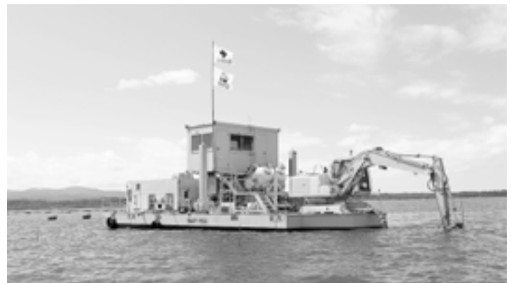
地元網走湖での浚渫工事
