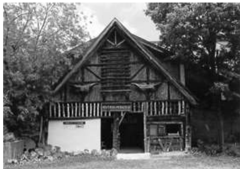
「川村カ子ト アイヌ記念館」の正面。開設は1916年にさかのぼるが、1963年に火災に遭って新改築され、川村家の縁戚にあたる木彫家・砂澤ビッキが外装デザインを担当した。撮影：筆者
