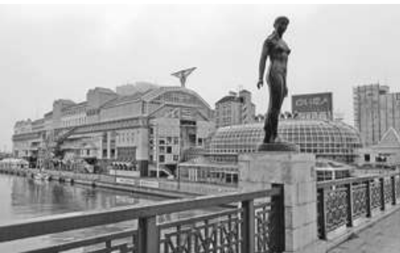
幣舞橋から見た「釧路フィッシャーメンズワーフ MOO」。毛綱毅曠の代表作のひとつで、外壁は薄い青、白、サーモンピンクの3色。市場や物産店、飲食店などの入った公共施設で、右にガラス屋根の大温室EGG(常緑庭園)が隣接する。なお、橋に立つ彫像は舟越保武作。4人の著名彫刻家による四季の乙女像のうち「春」である。撮影：筆者
