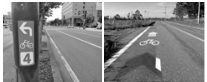
自転車走行環境の改善（案内看板と路面表示）（提供：北海道開発局）
