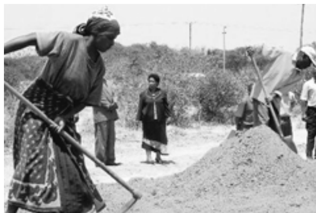
写真8 LBTによる道路建設・タンザニア（2007年）
